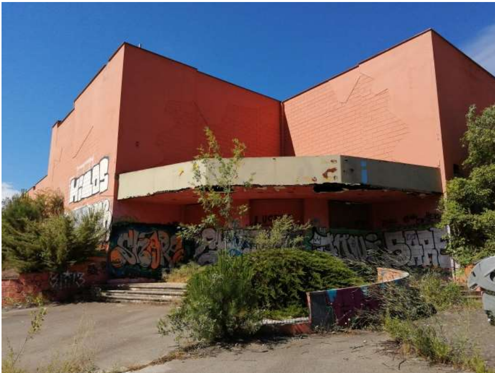
Estat actual de l'edifici de la discoteca. Foto: J. Palau.
