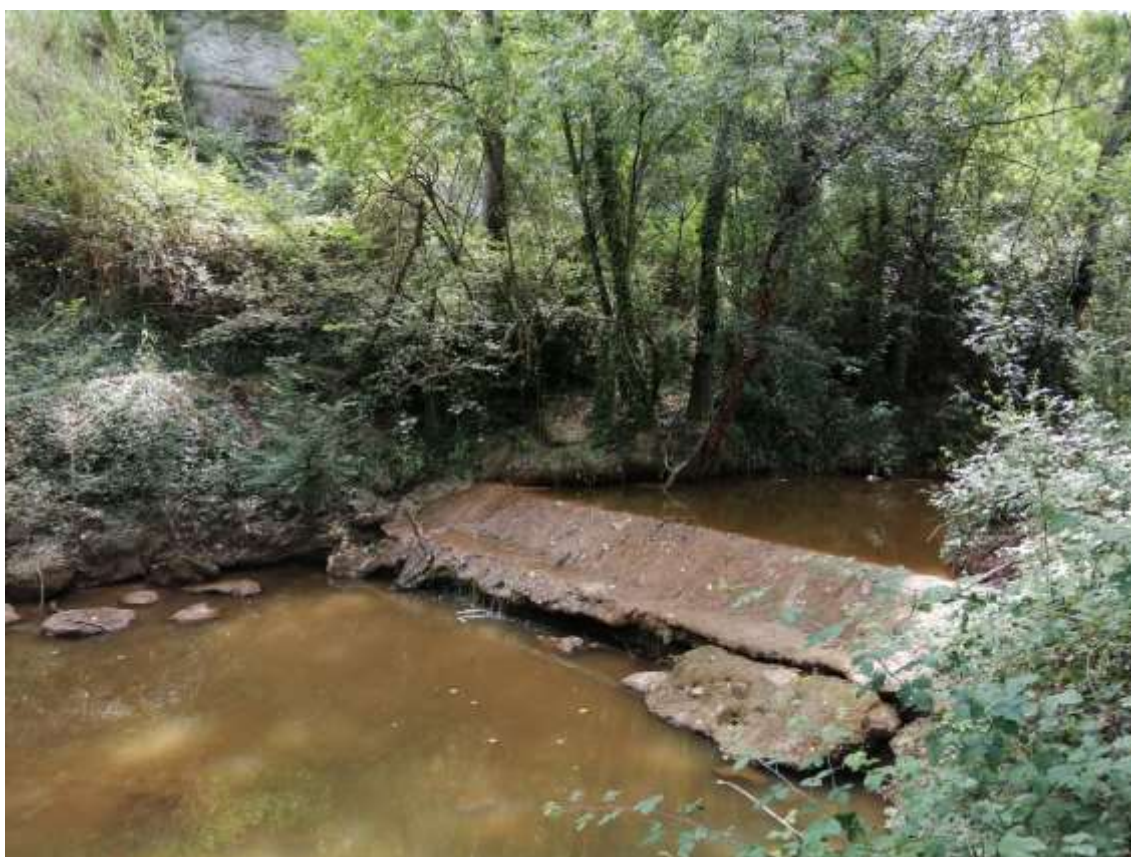
Vista del calaix de formigó existent a la riera de Rajadell. Foto: J. Palau.
